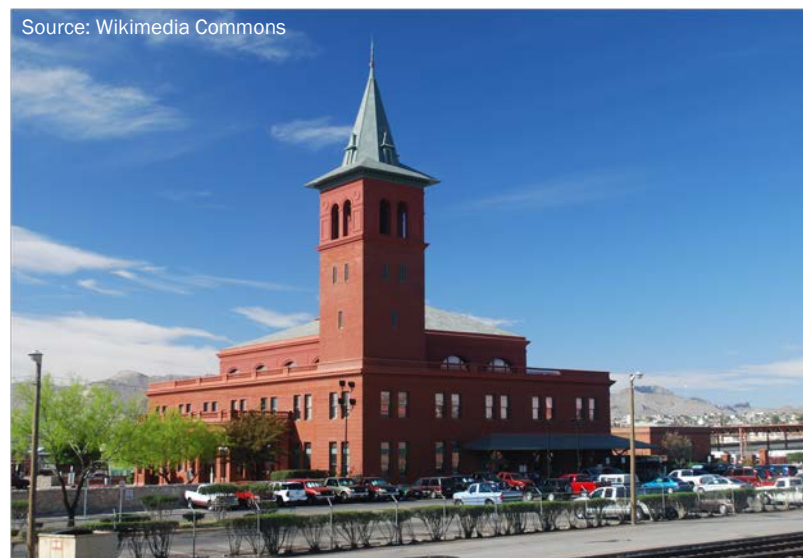
Source: Wikimedia Commons Figure 15: El Paso Union Depot
